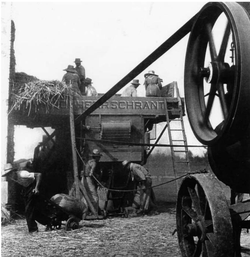
che, per mezzo di una grossa cinghia di trasmissione, metteva in movimento tutti i vari componenti della trebbiatrice che eseguivano contemporaneamente il lavoro del correggiato, delle cavalle, della ventilazione e della vagliatura.
