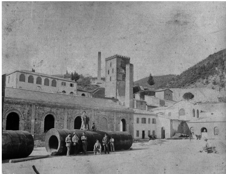
93 - Nell'immagine – che dovrebbe risalire al 1908 – vediamo alcune apparecchiature, rimosse dagli impianti di Caporciano e poste sul piazzale antistante lo stabilimento, in attesa di essere trasferite a Boccheggiano
