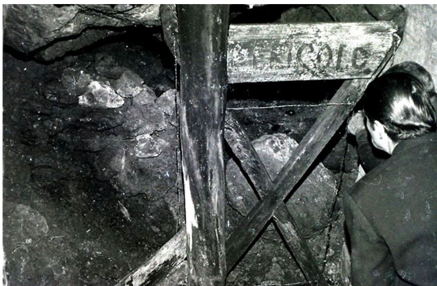
65 - L'accesso sbarrato alla vecchia miniera
